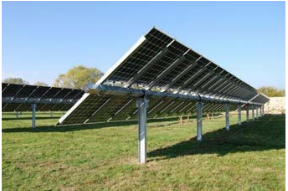
Figur 7. Foto af række med Tracker opstilling
